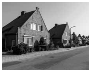
• Het complex arbeiderswoningen aan de Worth Rhedenseweg voor de recente onderhoudsuitvoering.
